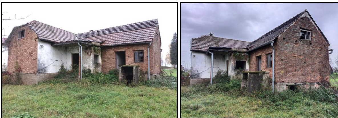
Slika 2.1-3. Obiteljska stambena zgrada na području planiranog zahvata
